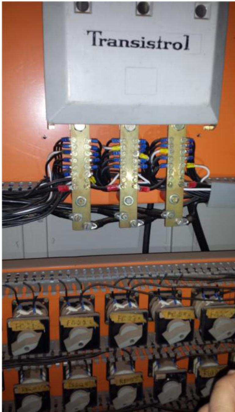
Pelas fotos as seta de cor azul indica a chave fusível existente. Na chave esta chegando cabo 2x#150,00mm<sup>2</sup>/Fase ;
