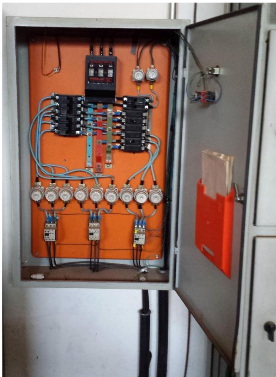
Na foto acima mostra a parte interna do quadro de iluminação externa que deverá ser adequado em novo quadro e relocado conforme indicação da engenharia e/ou manutenção elétrica do HC-FMB.
