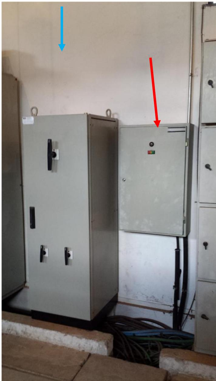
Na foto a Seta de cor vermelha indica o quadro de iluminação externa que deverá ser readequado e em novo quadro e instalado na posição indicada pela seta de cor Azul.
